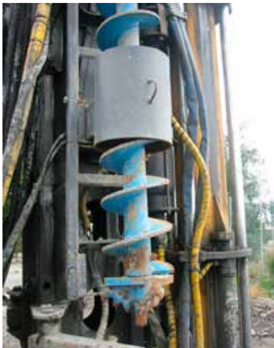
Bild 5. Augerborr på en pålkran.
