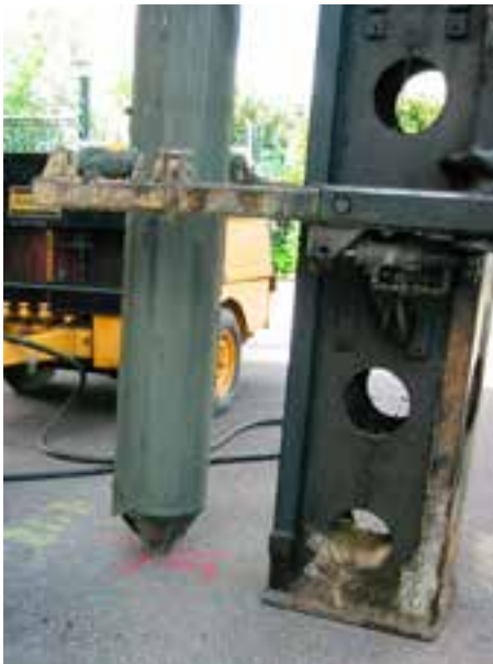
Bild 3. Pryl av stålrör med bergsko.
