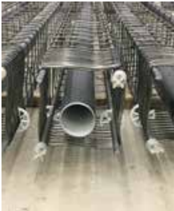
Bild 7. Energipåle innan gjutning
